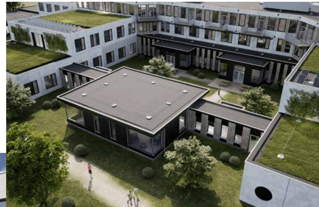
Centrale patio met paviljoens.
